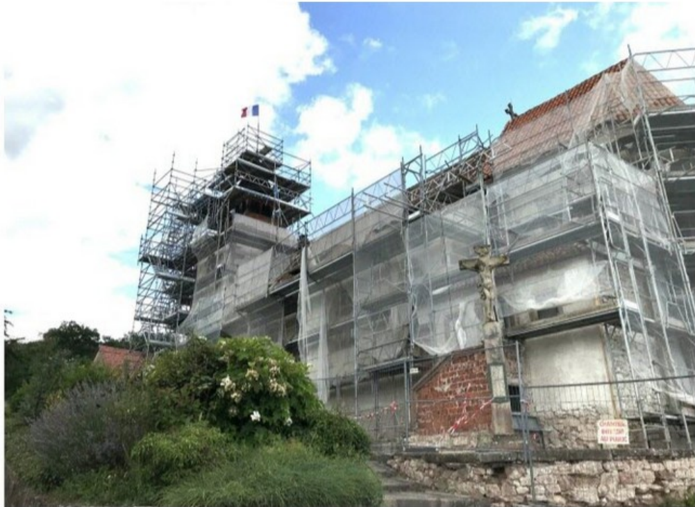
La chapelle s'est parée d'un échafaudage. Photo Philippe Schuhler
