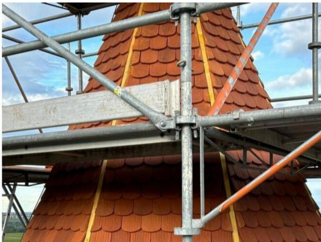
Des tuiles rouges traditionnelles ont remplacé les bardeaux. Photo DR
