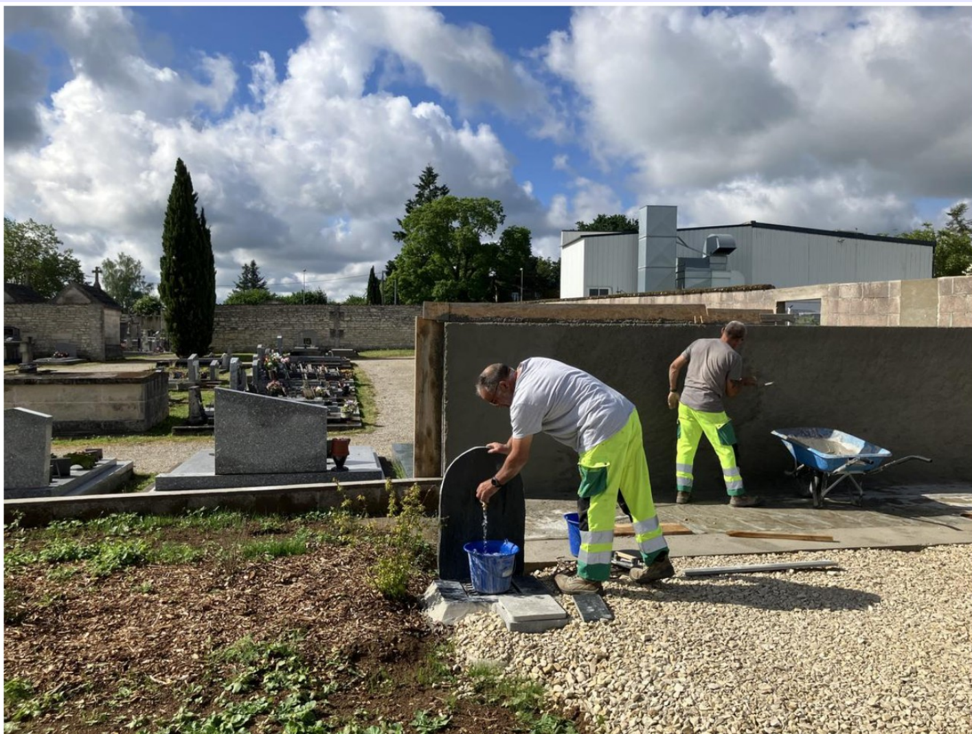
📷 Les agents municipaux sont en train de créer un espace dédié au tri des déchets.
