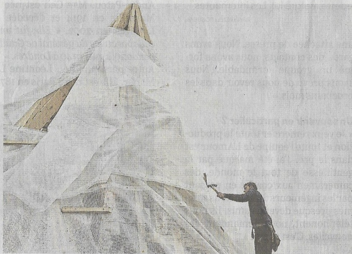
Le nouveau beffroi et la nouvelle flèche de l'église de Saint-Léger-de-Montbrun ont été installés
