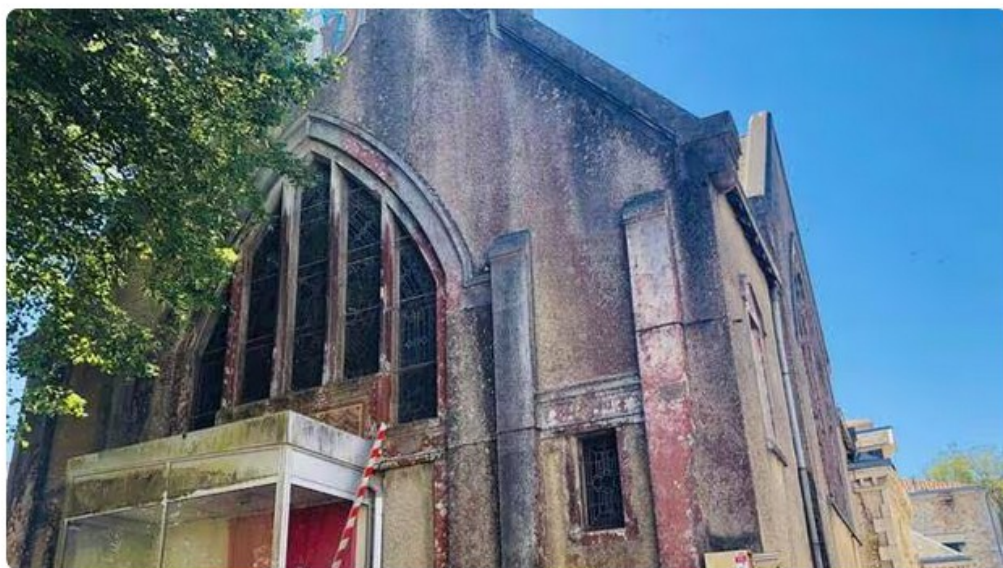
Les travaux de transformation de la chapelle de l'ancien hôpital de Parthenay ont débuté. | ARCHIVES CO – JORDAN GUERIN-MORIN
