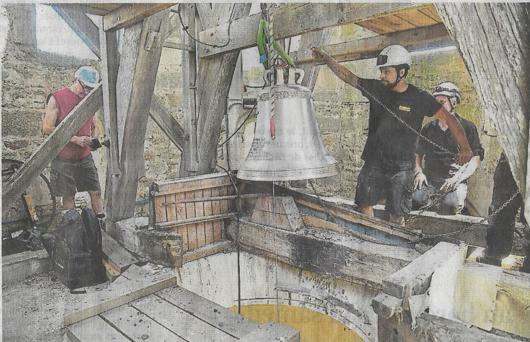
Saint-Varent, lundi. La cloche de 271 kg a été hissée à l'aide d'un simple filin. Un transfert en douceur. PHOTO : CO-MARE DELAGE
